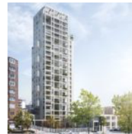
Torre Milano, via Stresa 22, OPM (Impresa Rusconi e Storm.it)
